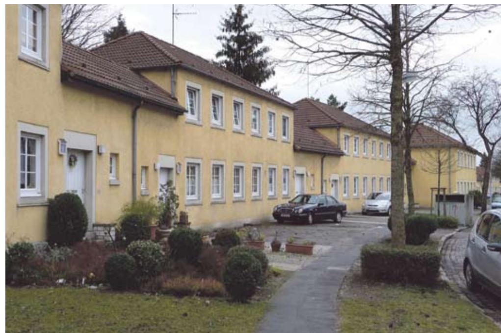
Die Fassaden der denkmalgeschützten Saliersiedlung erstrahlen bald in neuem Glanz.
