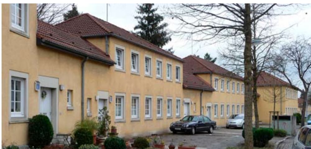
Die Saliersiedlung wurde von 1926 bis 1929 von der Stadt Mülheim errichtet. 1991 wurde sie Eigentum der MWB.
